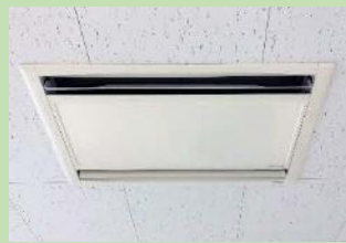
天井設置の熱交換換気
